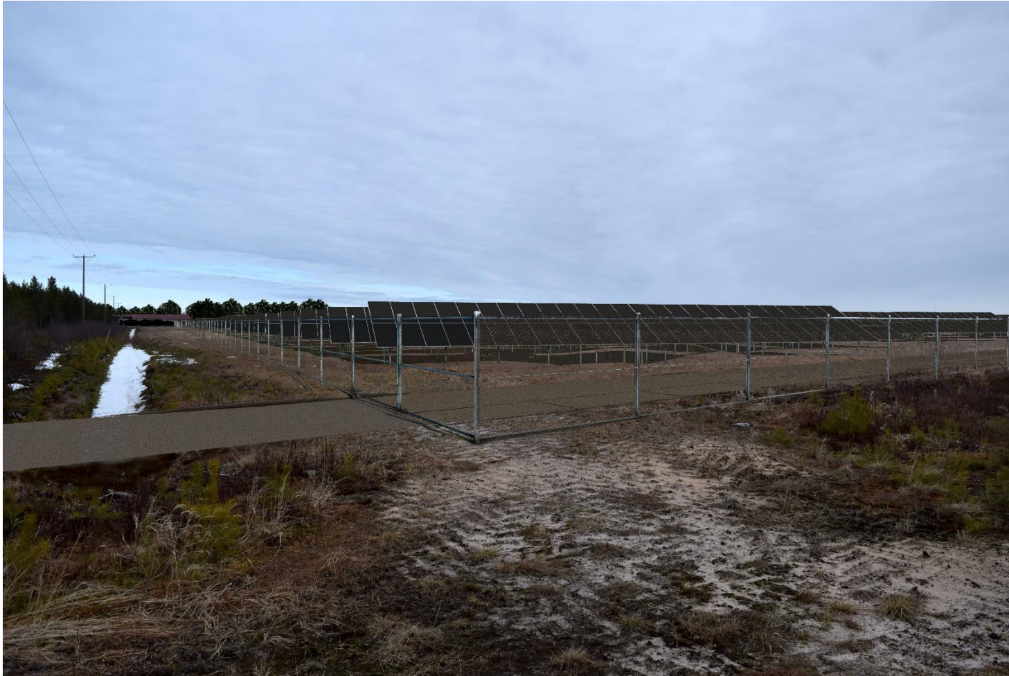
Kuva 13. Voimalat, aita ja maisemointi. Paneelirivit ovat sijoitettu länsi-itäsuuntaisesti. Kuvauspaikka on syrjässä ihmistoiminnalta keskellä hankealuetta. Kuvan taka-alalla olevan navetan ympärille sijoitettu kasvillisuus peittää sen näkymän voimala-alueelle.
