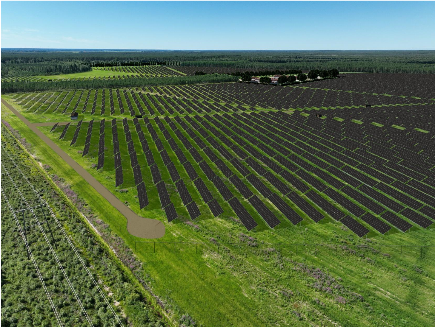
Kuva 7. Aurinkovoimalat sekä maisemointi. Paneelit asennettu kiinteisiin telineratkaisuihin, joissa paneelit suunnataan 25–30 asteen kulmassa etelään. Paneelirivit ovat länsi-itäsuuntaisesti. Vaikka osa metsää on poistettu, voimaloita ympäröi edelleen metsä ja puustot. Keskellä sijaitsevan navetan ympärillä oleva puusto estää näkymän aurinkovoimalapuistoon.
