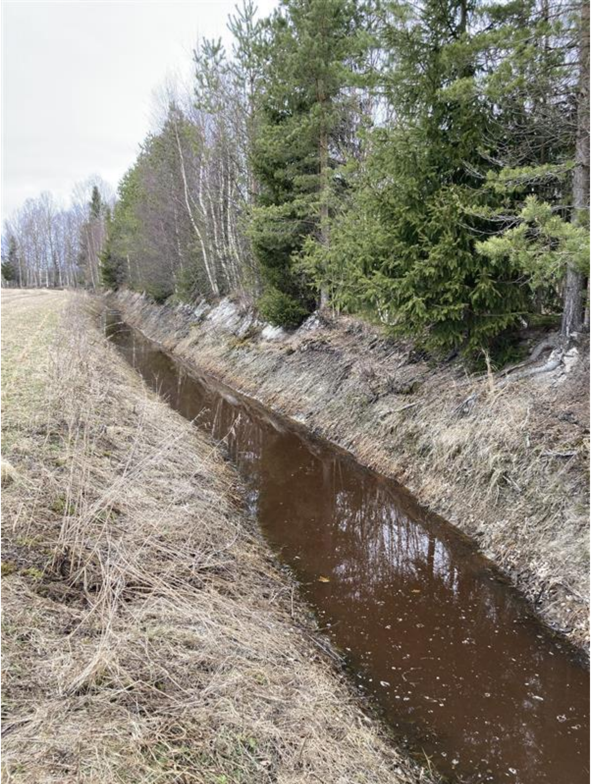
Kuva 16. Kaksitasouomaksi rakennettava oja 3
