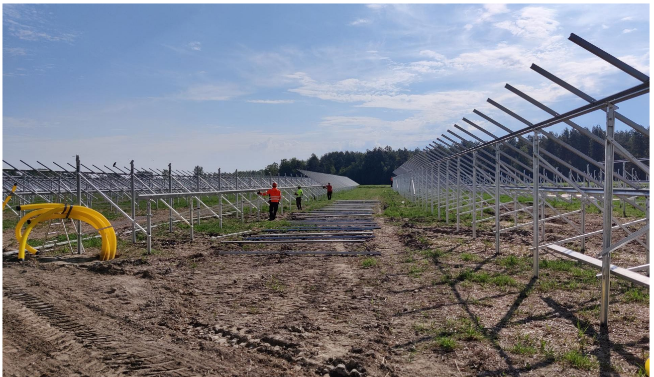
Telineiden rakentaminen Ruotsinojan aurinkopuiston työmaalla kesällä 2024
