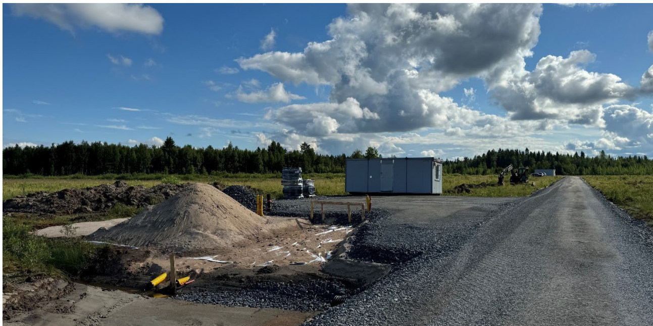
Muuntamokentän rakentaminen Loukkaanaron aurinkopuistossa kesällä 2024
