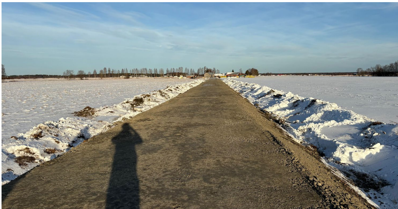
Kivennäismaan päälle rakennettu huoltotie Vimparin aurinkopuiston työmaalla talvella 2025
