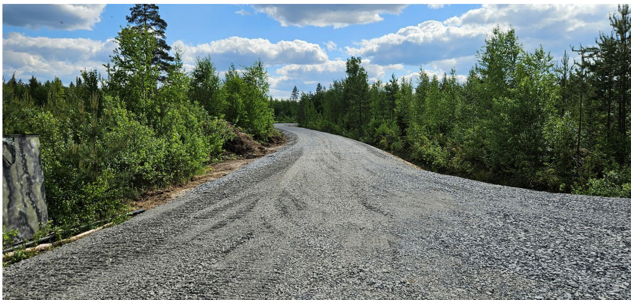
Kivennäismaan päälle rakennettu huoltotie Loukkaanaron aurinkopuiston työmaalla kesällä 2024
