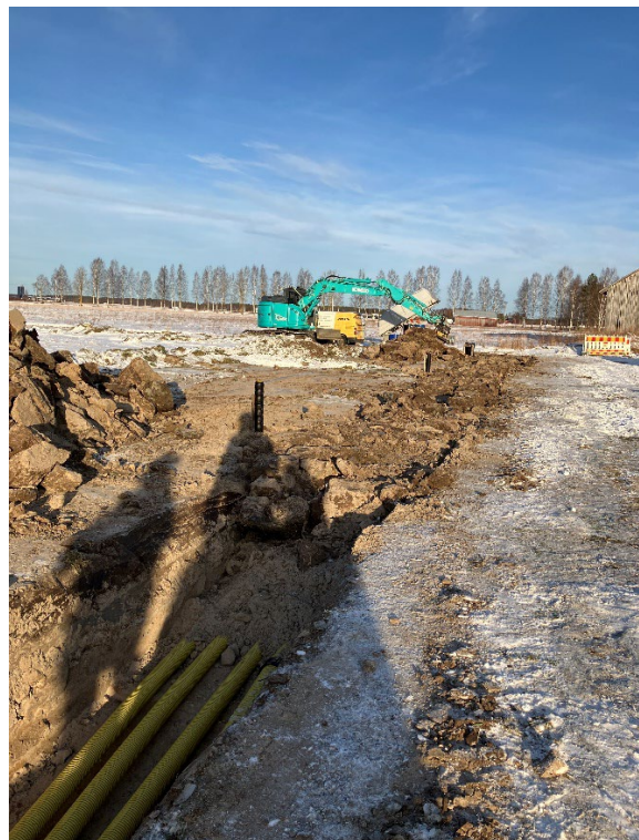
Aurinkopuiston sisäinen kaapelikaivanto Vimparin aurinkopuistotyömaalla Muhoksella talvella 2025.
