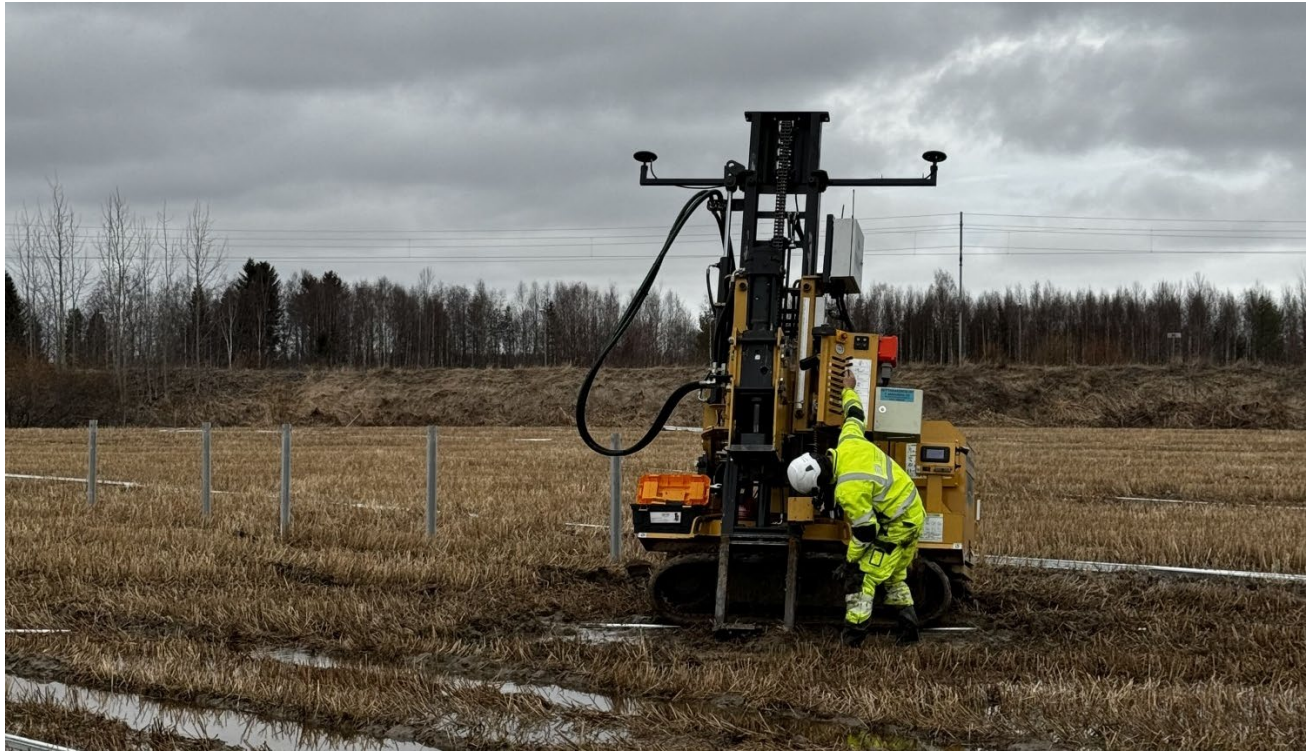
Teloilla kulkeva paalutuskone Ruotsinojan aurinkopuiston työmaalla keväällä 2024
