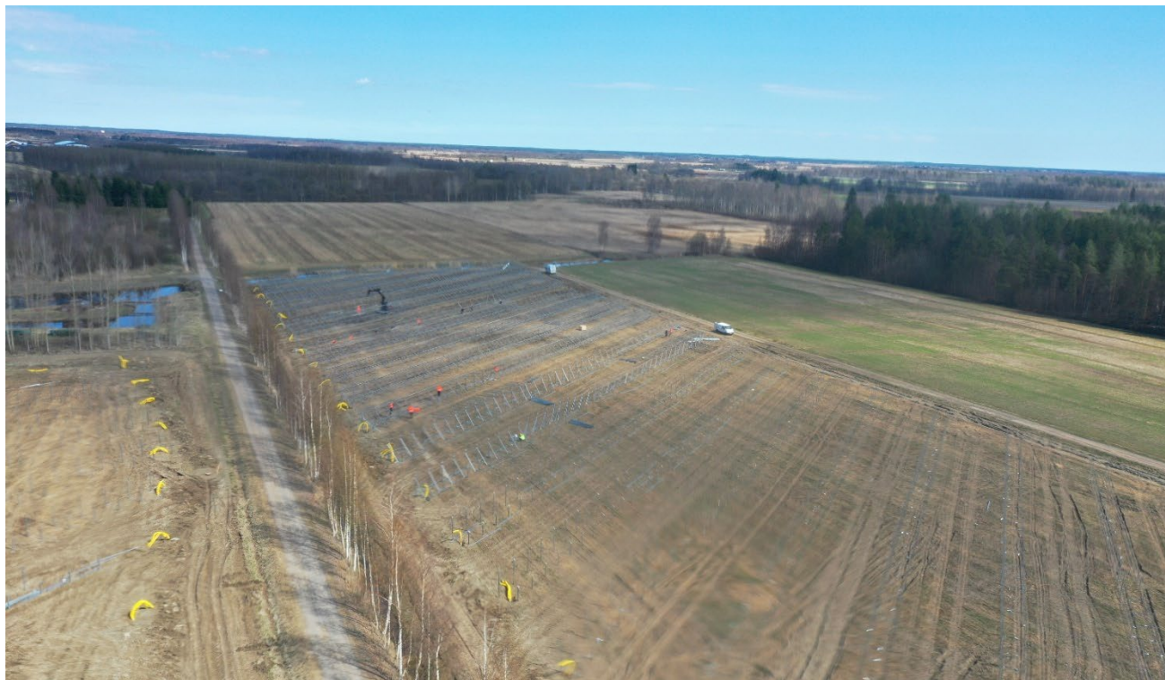
Paalutus ja materiaalin jakoa Ruotsinojan aurinkopuiston työmaalla keväällä 2024
