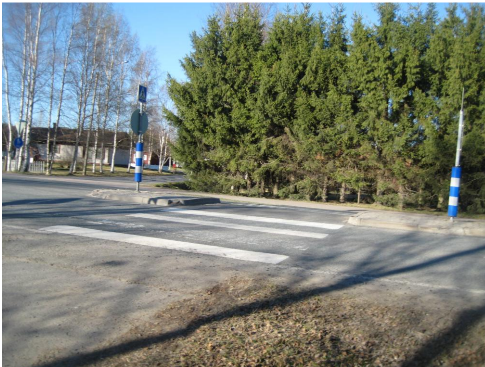
Kuva 42 (oikealla). Suojatiesareke Kuulammen koulun kohdalla (kohde B7 ).
