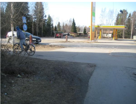
Kuvat 23 ja 24 yllä. Korotetun suojatien kohdalla luiskamaton reunatuki ja ajoradan viiste, joka voidaan virheellisesti tulkita jalkakäytävän varoitusalueeksi. Kuvassa 22 näkyy valaisinpylvään "torso" jalkakäytävän keskellä. (kohde B3)
