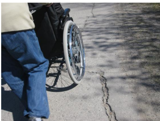
Kuva 15 vasemmalla. Kevyen liikenteen väylän päällystevaurioita. Pinnan halkeamat vaikeuttavat pyörötuolilla liikkumista. (kohde A1)
