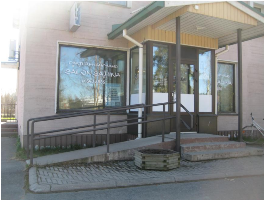
Kuva 12. Liikerakennuksen sisäänkäynti, portaat ja luiska
