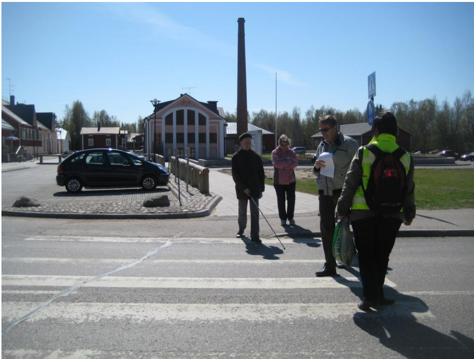
Kuva 20. Vanha- tien suojatie sivussa Meijeri- tien kevyen liikenteen väyläl- tä (päättyy kor- keaan tu- keen). Meijeritien liittymästä ja suojatien kohdal- ta puuttuu oh- jaavat reunatuet. (kohde B1)
