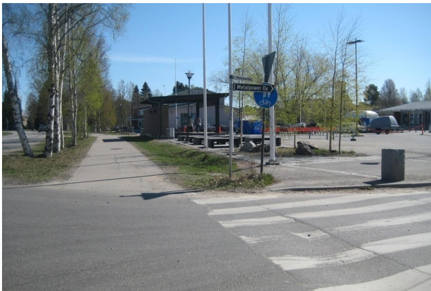
Kuva 5. Suojatiemerkinä kevyen liikenteen väylän jatkona ja suojatiemerkki puuttuvat Ketolantien liittymässä
