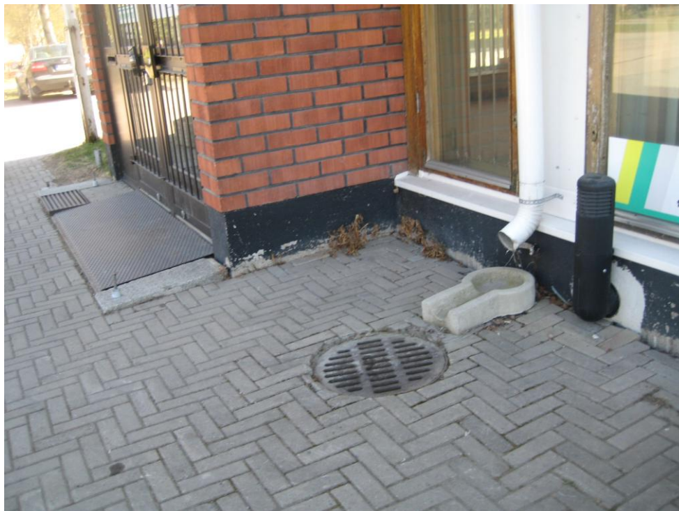
Kuva 31. Liikera- kennus Vanhatie, K –maatalouden ovessa esteetön sisäänkäynnin luiska, oven auki- pitotappeihin voi kompastua (kohde D5)
