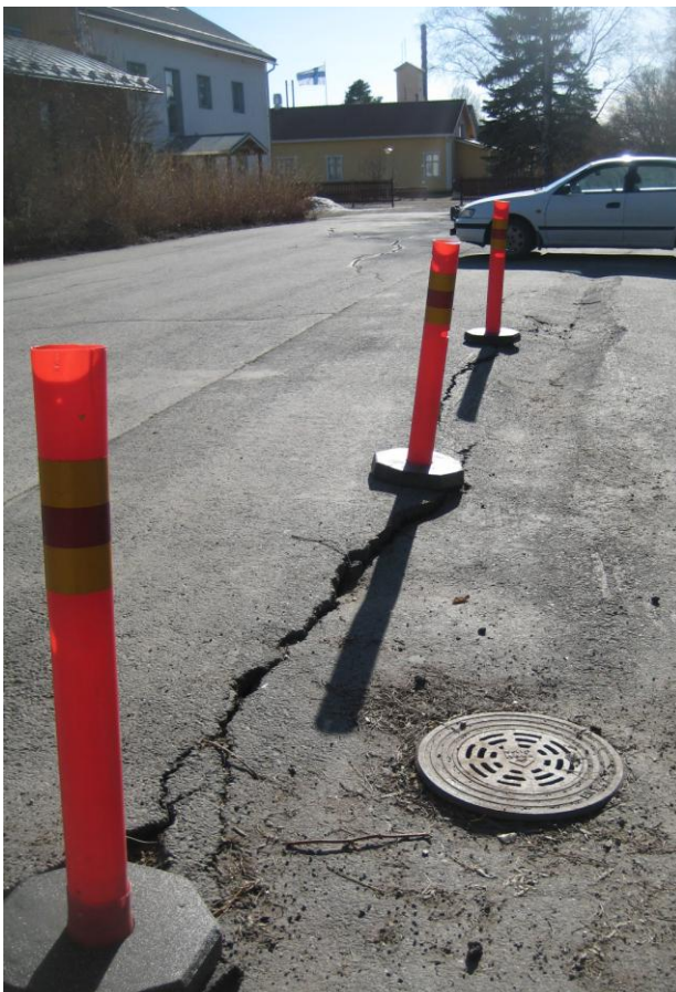
Kuva 34. vasemmalla. Routavaurioita Kirkkomännikön kulun pysäköintialueella. (kohde B5)
