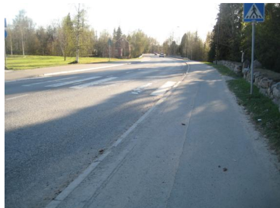
Kuva 15 vasemmalla. Kevyen liikenteen väylän päällystevaurioita. Pinnan halkeamat vaikeuttavat pyörötuolilla liikkumista. (kohde A1)
