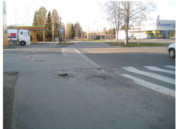
Kuvat 23 ja 24 yllä. Korotetun suojatien kohdalla luiskamaton reunatuki ja ajoradan viiste, joka voidaan virheellisesti tulkita jalkakäytävän varoitusalueeksi. Kuvassa 22 näkyy valaisinpylvään "torso" jalkakäytävän keskellä. (kohde B3)
