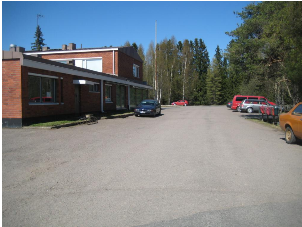
Kuva 26. Kunnankujan alkuosa – jäsen- tymätön katuti- la, jossa liikku- misesteisen tai näkövammai- sen on vaikea kulkea. (kohde B4 )
