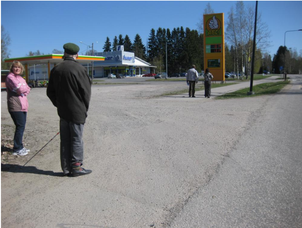
Kuva 17. Jatkuvuus- / ohjauksipuute Vanhatie 7 liittymässä. Näkövammaisen henkilö ei pysty havaitsemaan reittiä erillisen ja kototetun kevyen liikenteen väylän välillä. (kohde A2)
