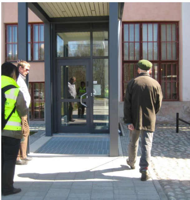
Kuva 11. Kirjaston pääsisäänkäynti. Oven aukaisupainike on asennettu oven oikealla puolella olevaan pilariin.
