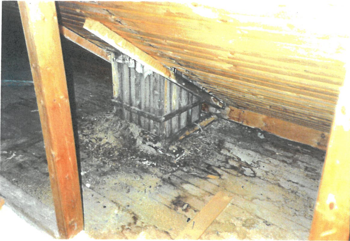
Kuva 39. Lahovaurioita ja laakakääpäkäsivustoa puulla verhotun ilmanvaihtohormin vesikaton lävistyskohdan alapuolella soitinhuoneen yläpuolisen tilan itäseinustalla.
