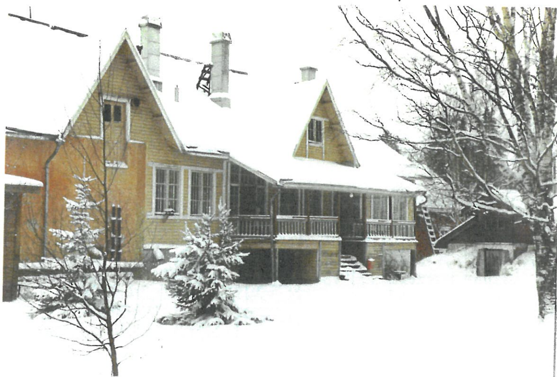
Kuva 21. Pesularakennuksen puuosan julkisivu rakennuksen itäsi- vulla.
