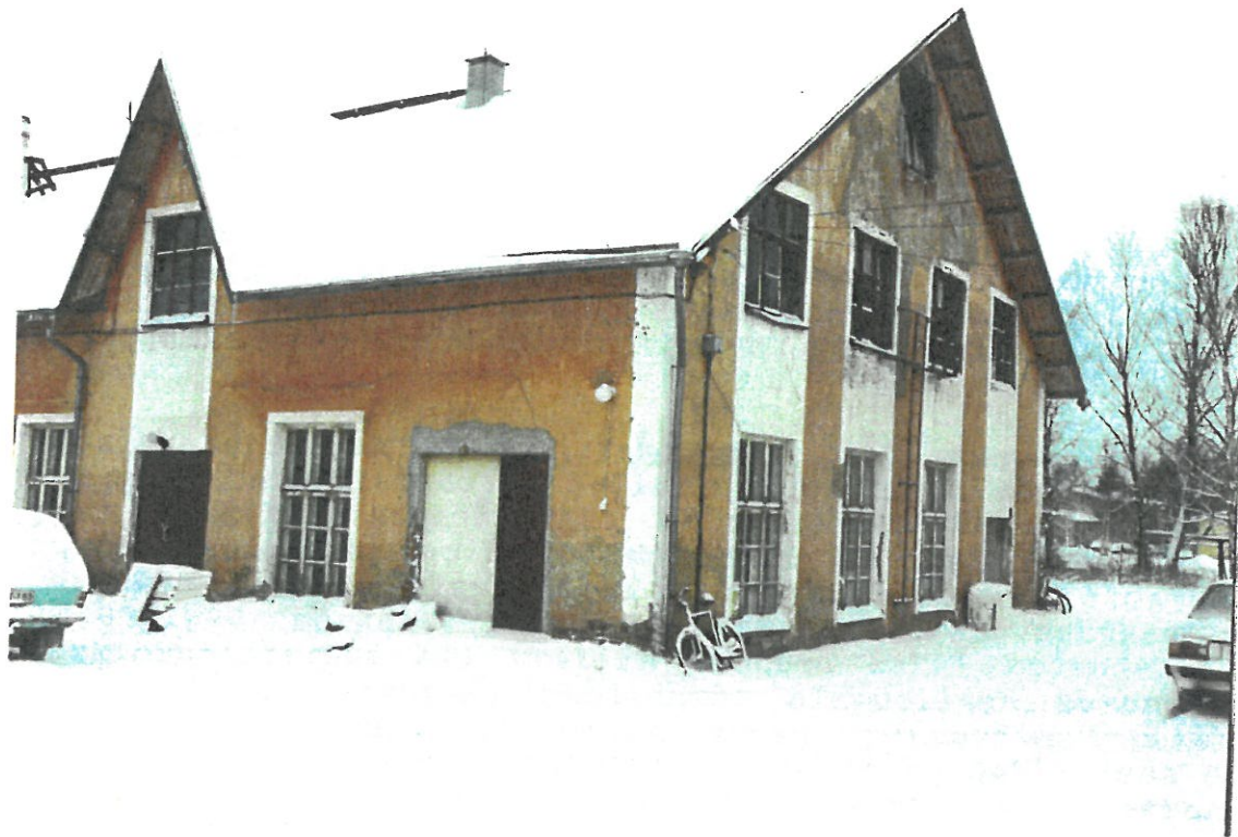
Kuva 20. Pesularakennuksen kivosan julkisivua rakennuksen lounaisnurkalta.
