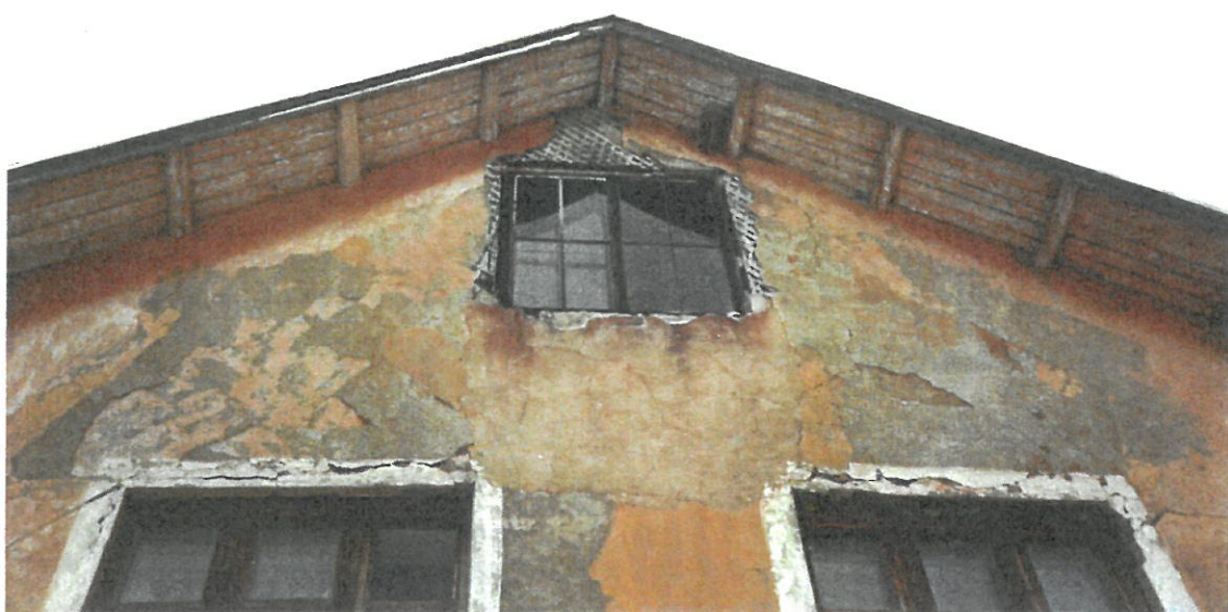
Kuva 30. Vaurioitunutta ja osittain "paikattua" tikkurappausta pesulan eteläpään päätykolmiossa.
