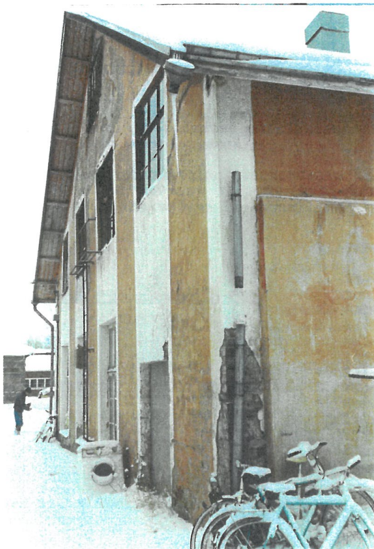
Kuva 30. Vaurioitunutta ja osittain "paikattua" tikkurappausta pesulan eteläpään päätykolmiossa.
