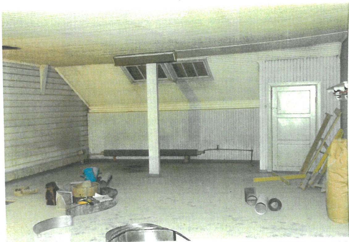
Kuva 19. Valokuva toimistotilan 202 katto-, seinä- ja lattiapi- noista.
