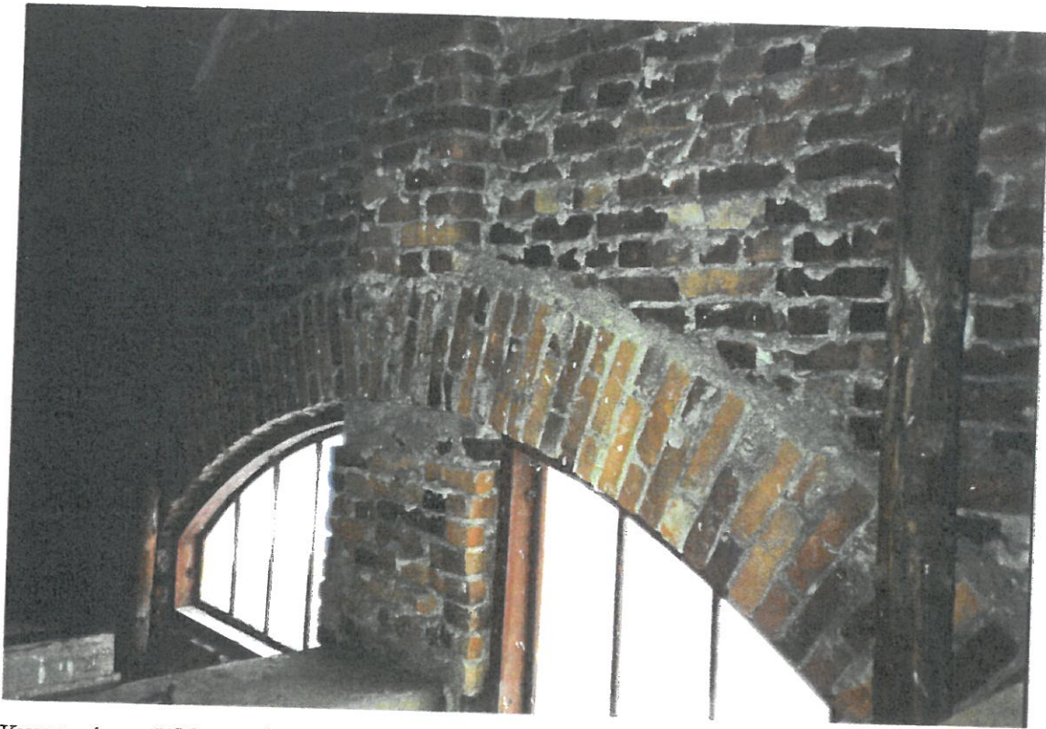
Kuva 4. Ulkoseinärakenteen tiilipilari ja -holvi kattilahuoneen yläpuolisessa ullakkotilassa länteen avautuvassa "päädyssä".
