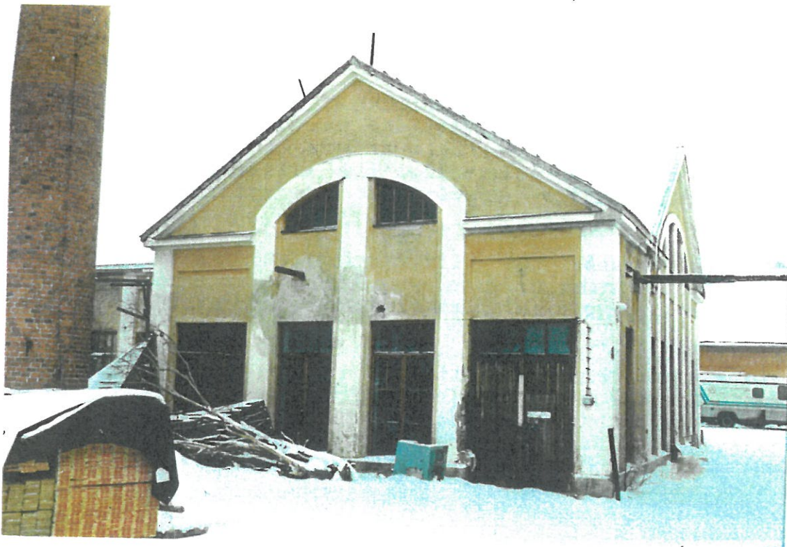
Kuva 2. Rakennuksen ulkoseinäpintaa kattilahuoneen kohdalta lounaisnurkasta.
