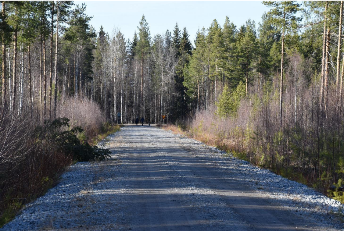
Kuva. Voimassa olevan asemakaavan mukaisesti rakenteilla oleva Setolkan katu kohti Isosuontietä. Kadulta on väistämisvelvollisuus.
