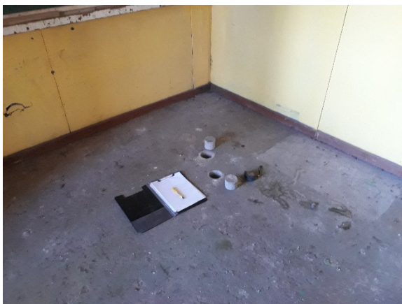
Kuva 8. Alapohjan rakenneavauskohta AP1.
