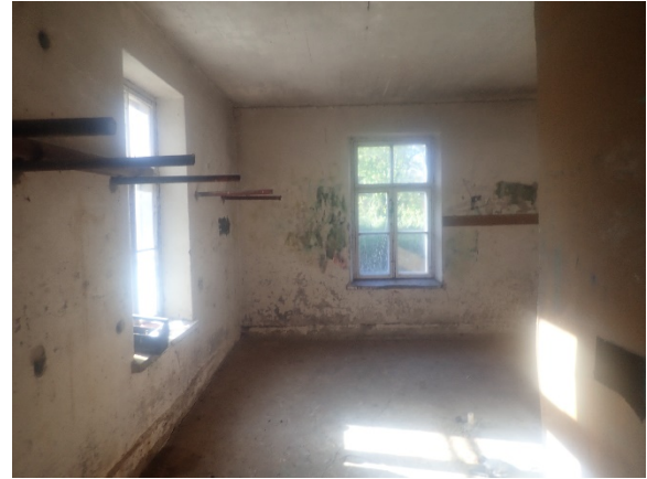
Kuva 2. Yleiskuva rakennuksen päädyssä olevasta tilasta.
