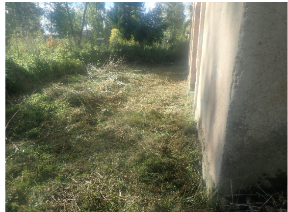
Kuva 59. Maanpinnan kallistukset ovat loivat. Kuva on etupihalta katsottuna oikeanpuoleista päädyestä.
