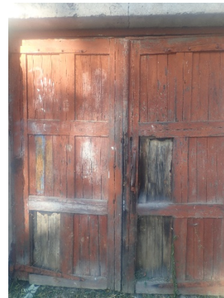
Kuva 23. Yleiskuva päädyssä olevasta pariovesta.
