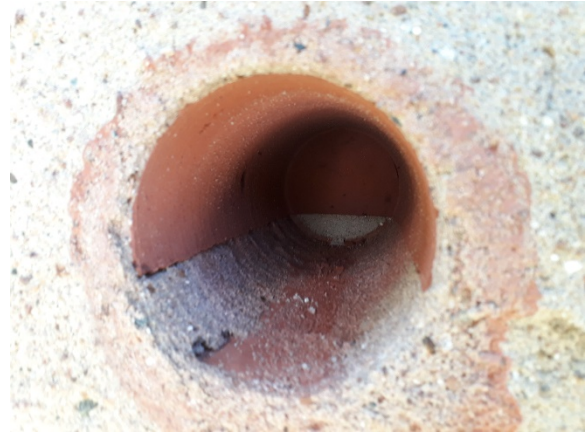
Kuva 31. Kuva avauksesta US2. Tiilissä ja niiden saumauksissa ei havaittu avauskohdalla vaurioita.
