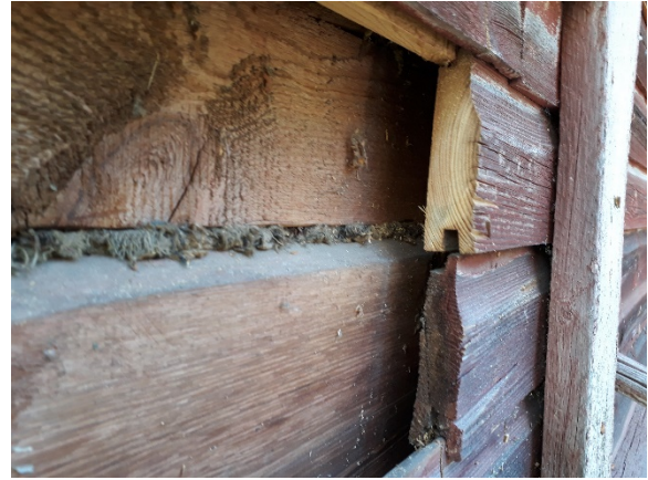
Kuva 35. Kuva avauksesta US4. Laudoituksen takana on noin 20 mm tuuletusrako.
