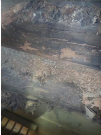
Kuva 44. Yleiskuva välipohjan rakenteista portaikon läheisyydestä.
