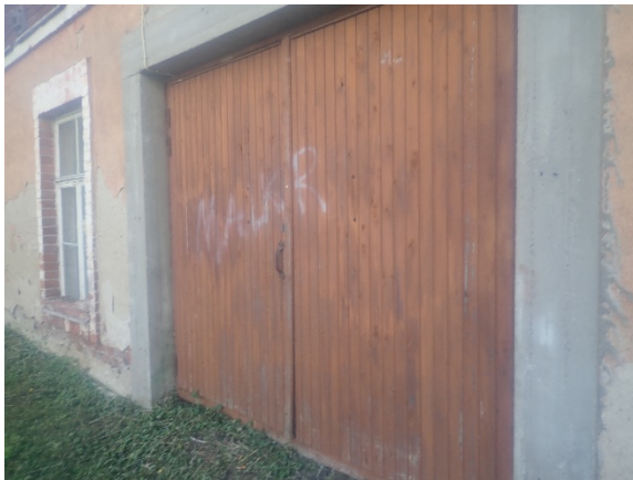
Kuva 22. Yleiskuva takapihan puoleisesta pariovesta.
