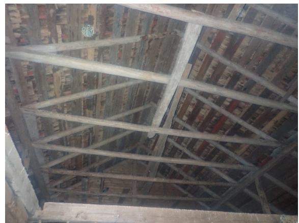
Kuva 51. Yleiskuva vesikaton alapuolisista raken- teista.
