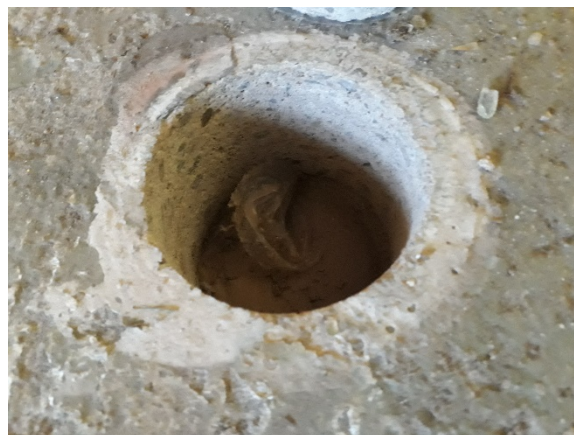
Kuva 9. Betonilaatan alla oli muovikalvo ja hiekkaa.
