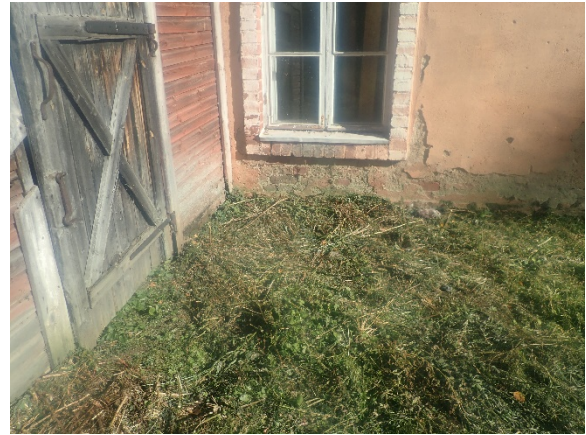
Kuva 61. Maanpinta ulkoseinän puuosien alaosien tasossa.
