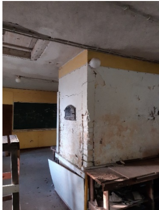
Kuva 42. Yleiskuva alakerrassa olevasta tulisijasta.
