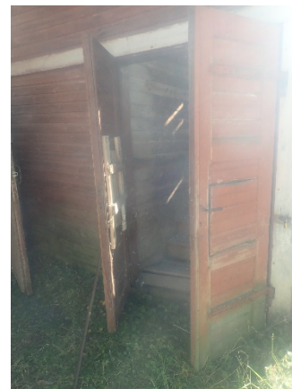
Kuva 25. Yleiskuva portaikkoon johtavasta pariovesta
