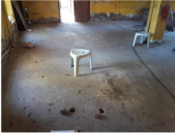
Kuva 10. Alapohjan rakenneavauskohta AP2.
