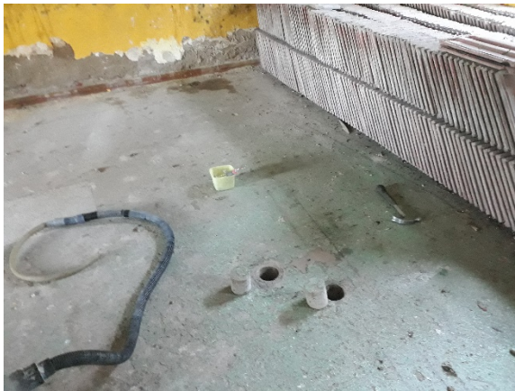
Kuva 12. Alapohjan rakenneavauskohta AP3.
