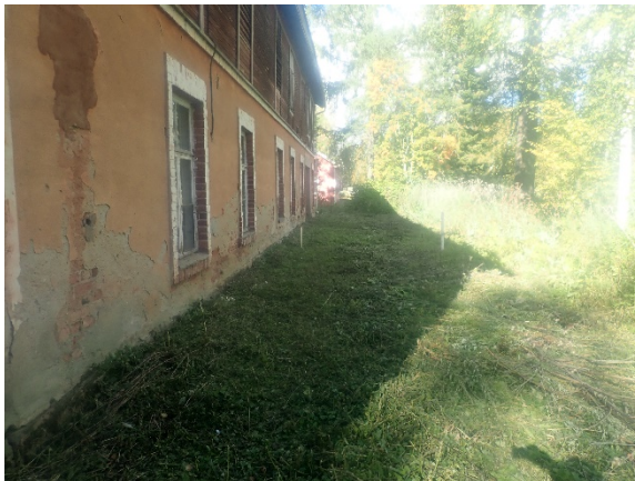
Kuva 58. Maanpinnan kallistukset ovat loivat. Kuva on takapihan puolelta.
