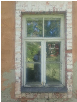
Kuva 16. Yleiskuva alakerran ikkunoista.
