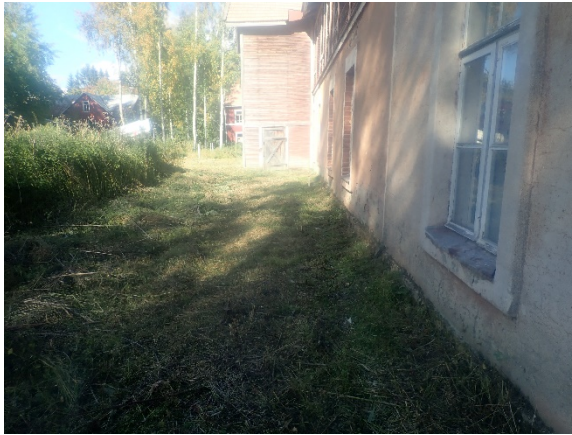
Kuva 60. Maanpinnan kallistukset ovat loivat. Kuva on etupihan puolelta.
