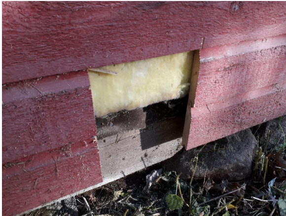
Kuva 31. Yleiskuva ulkoseinän rakenneavauksen US1 kohdalta rakennuksen matalalta osalta. Avauskohdalla ei ollut rakenteessa tuuletusrakoa.
