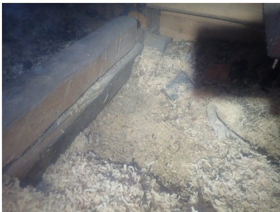
Kuva 65. Rakenneavaus YP1 tehtiin väli- ja ulkoseinän vierustalle joen puolella.
