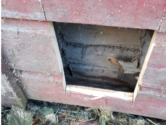
Kuva 33. Yleiskuva ulkoseinän rakenneavauksen US4 kohdalta rakennuksen takaa korkealta osalta.
