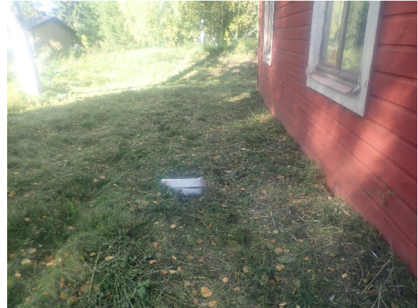
Kuva 71. Maanpinnan kallistukset ovat loivat. Ulkoseinien alaosien puuosat ovat maanpinnan alapuolella. Kuva on korkean osan päädyssä.
