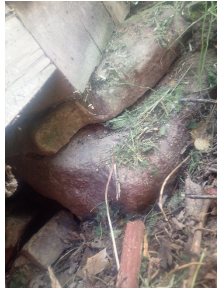
Kuva 27. Päädyssä olevan kappaletavarasta tehdyn osan kohdalla on luonnonkivistä tehtyt pilariperustukset.
