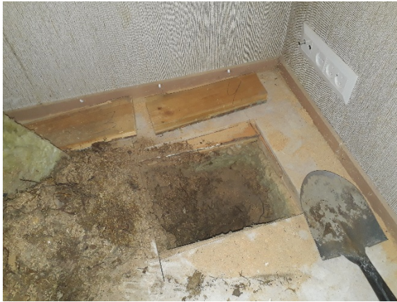
Kuva 8. Yleiskuva alapohjan rakenneavauksen AP3 kohdalta.
