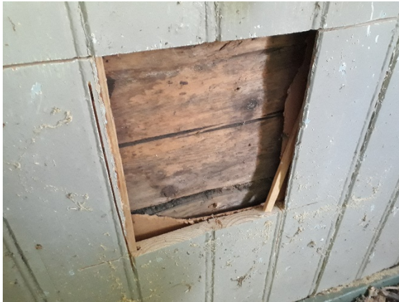
Kuva 35. Yleiskuva ulkoseinän rakenneavauksen US5 kohdalta ikkunan alta.
