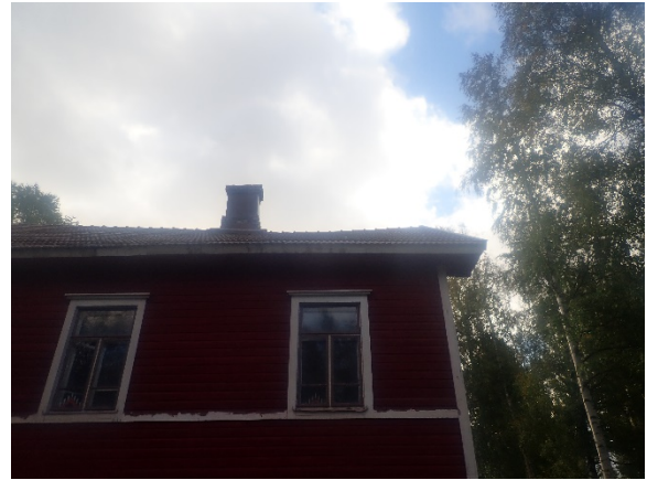
Kuva 58. Korkean osan lappeen taipumaa takapihalta katsottuna.
