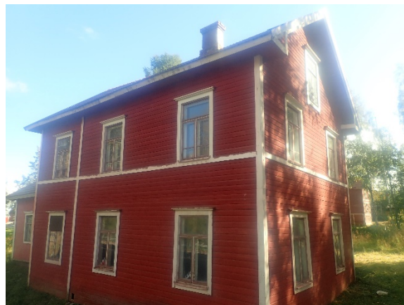
Kuva 13. Yleiskuva julkisivuverhouksesta takapihan puolelta ja päädyistä.
