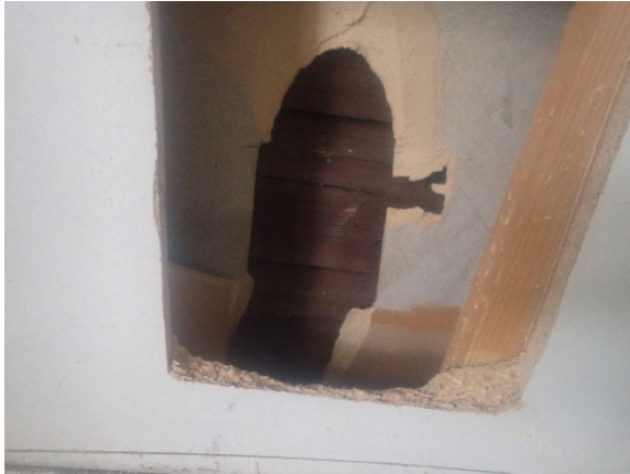
Kuva 53. Yleiskuva rakenneavauksen RAVS4 kohdalta.
