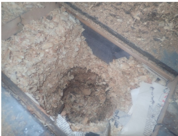
Kuva 47. Yleiskuva välipohjan rakenneavauksen VP1 kohdalta.
