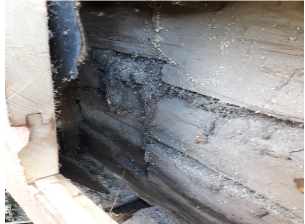
Kuva 34. Kuva rakenneavauksen US4 sisään. Lauta-verhouksen takana on tuuletusrako.
