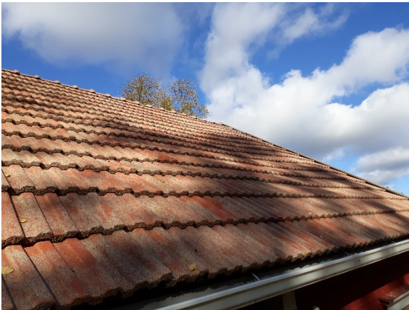
Kuva 59. Lappeen aaltoilua korkealla osalla.
