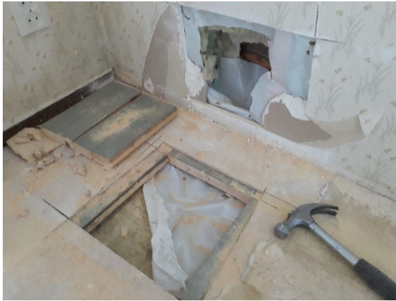
Kuva 10. Yleiskuva alapohjan rakenneavauksen AP4 kohdalta.
