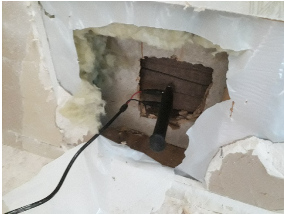
Kuva 39. Yleiskuva ulkoseinän rakenneavauksen US8 kohdalta. Kuvassa puupiikkimittaus.
