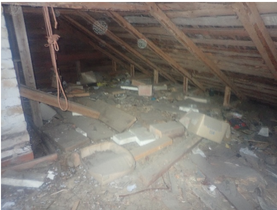
Kuva 61. Yleiskuva yläpohjasta korkealta osalta.
