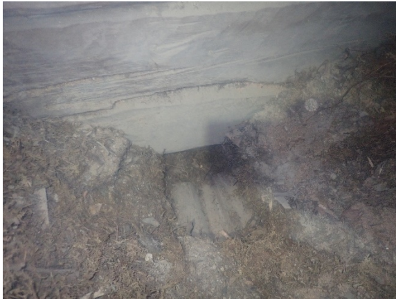
Kuva 67. Rakenneavaus YP2 korkean osan päätyseinän vierustalle.
