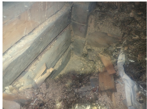
Kuva 66. Yleiskuva rakenneavauksen YP1 kohdalta.
