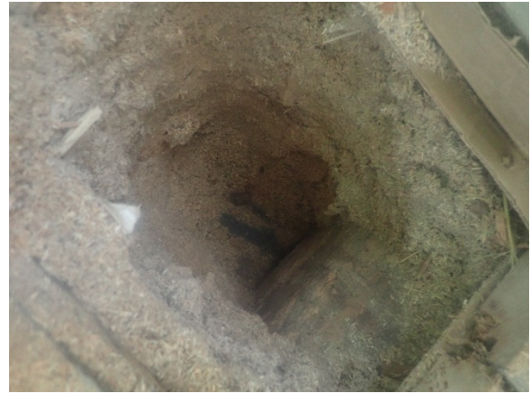
Kuva 49. Yleiskuva rakenneavauksen VP2 kohdalta.
