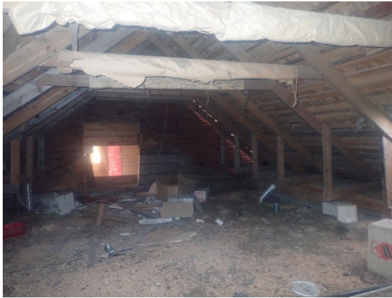
Kuva 63. Yleiskuva yläpohjasta matalalta osalta.
