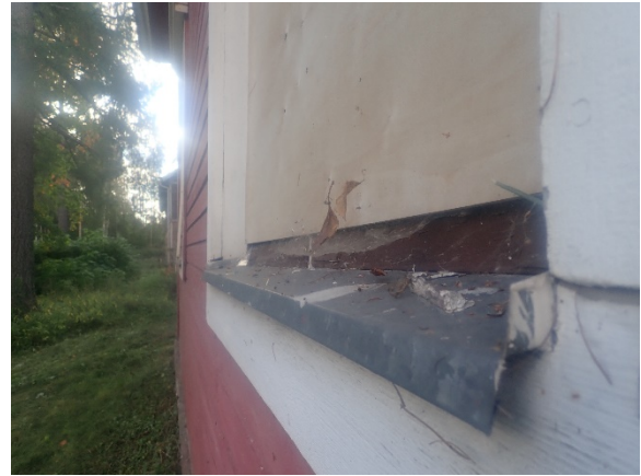
Kuva 19. Yleiskuva matalan osan ikkunan vesipellityksistä.
