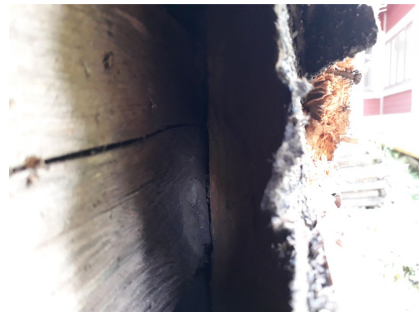
Kuva 30. Kuva rakenneavauksen US1 sisään. Ku- vassa näkyy lautaverhouksen takana oleva ilmatila.
