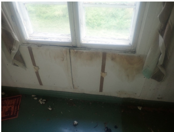
Kuva 22. Yleiskuva ikkunan vesipellityksestä korkealla osalla. Vesipellityksen. Liittymien kautta vesi pääsee ulkoseinärakenteisiin.
