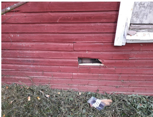
Kuva 29. Yleiskuva ulkoseinän rakenneavauksen US1 kohdalta etupihalta.
