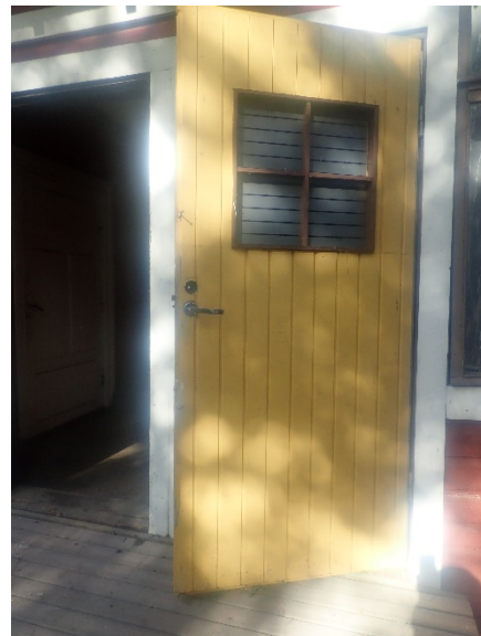
Kuva 25. Yleiskuva ulko-ovesta korkealla osalla.
