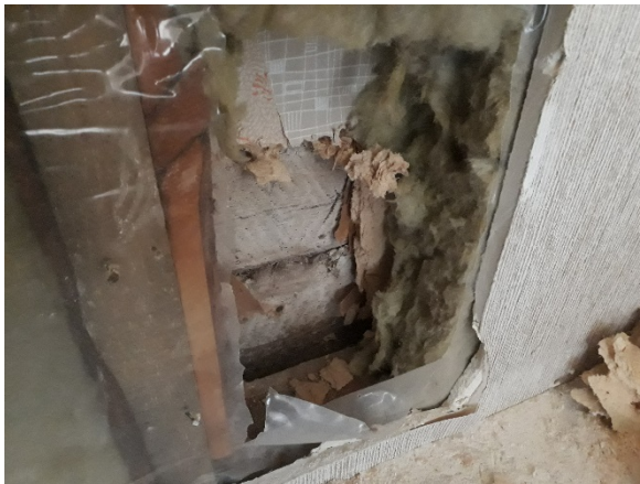
Kuva 38. Yleiskuva ulkoseinän rakenneavauksen US7 kohdalta matalan osan olohuoneesta.
