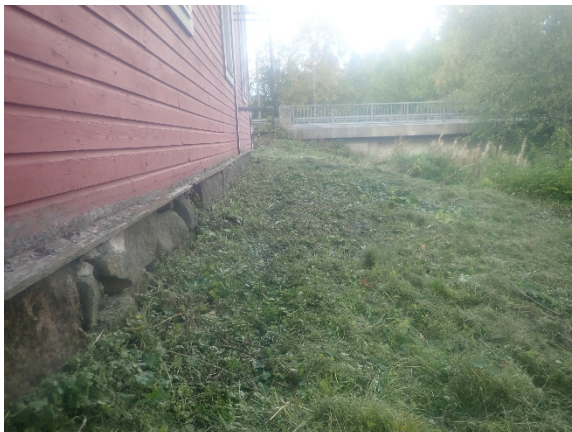
Kuva 28. Matalla osalla on kiviperustus. Kuva on takapihan puolelta. Takapihan puolella perustukset olivat eniten näkyvissä ja maanpinta viettää hyvin pois päin rakennuksesta.
