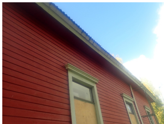
Kuva 17. Matalan osan julkisivua takapihan puolelta.
