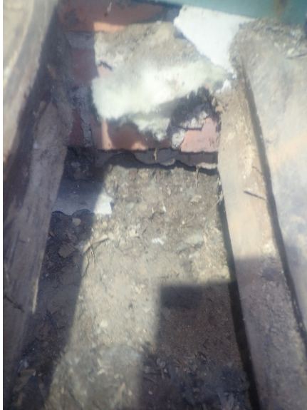
Kuva 7. Yleiskuva alapohjan rakenneavauksen AP2 kohdalta.
