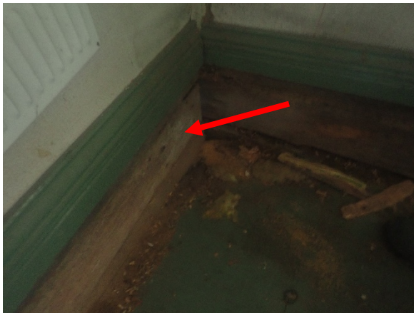
Kuva 52. Yleiskuva rakenneavauksen VS2 kohdalta. Näyte otettiin nuolella merkityn seinän sisältä.
