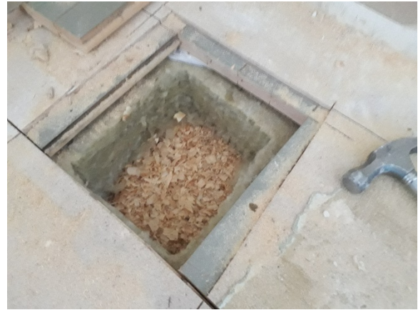
Kuva 11. Yleiskuva alapohjan rakenneavauksen AP4 kohdalta.
