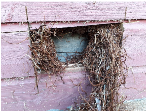
Kuva 32. Yleiskuva ulkoseinän rakenneavauksen US3 kohdalta. Avauskohdalla paneelin ja hirsirungon välissä oli kuntaa eristeenä. Rakenteessa ei ollut tuuletusrakoa.
