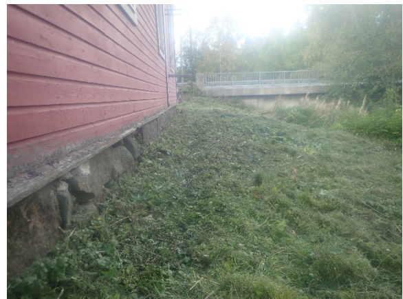
Kuva 73. Maapiinan kallistukset ovat rakennuksesta poispäin joen puoleisella sivulla.
