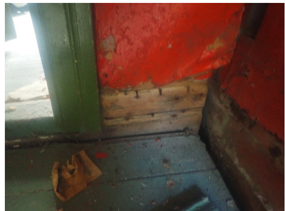
Kuva 51. Yleiskuva rakenneavauksen VS1 kohdalta.
