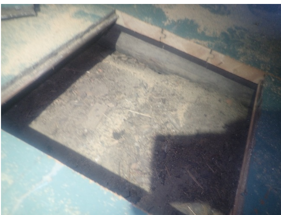
Kuva 5. Yleiskuva alapohjan rakenneavauksen AP1 kohdalta.
