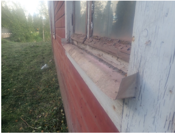
Kuva 22. Yleiskuva ikkunan vesipellityksestä korkealla osalla. Vesipellityksen. Liittymien kautta vesi pääsee ulkoseinärakenteisiin.
