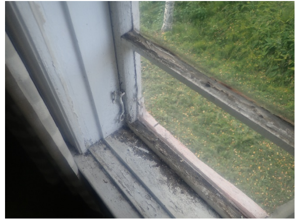
Kuva 23. Yleiskuva ikkunan puuoista sisäpuolelta.
