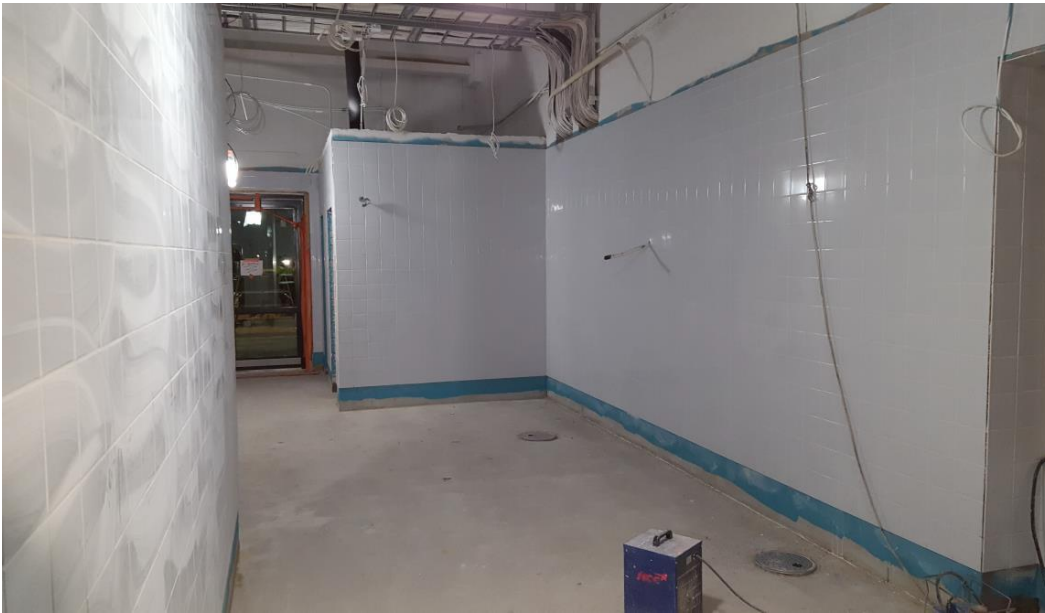
Keittiön laatoitettua seinää.
