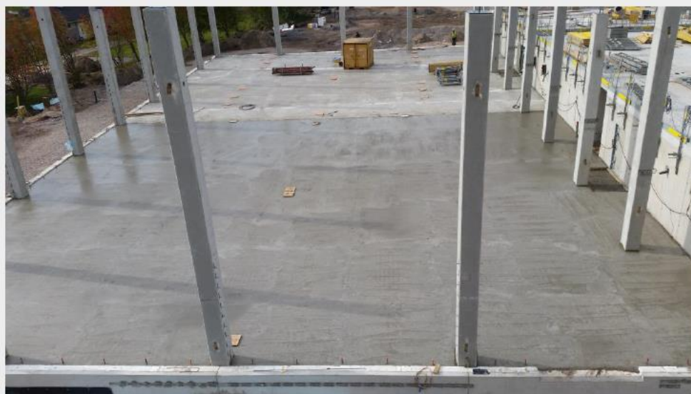
2. Liikuntasalin valettu paalulaatta
