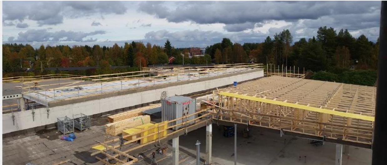
1. Taito- lohkon vesikaton rungon asennus ja aulaan asennetut ontelolaatat
