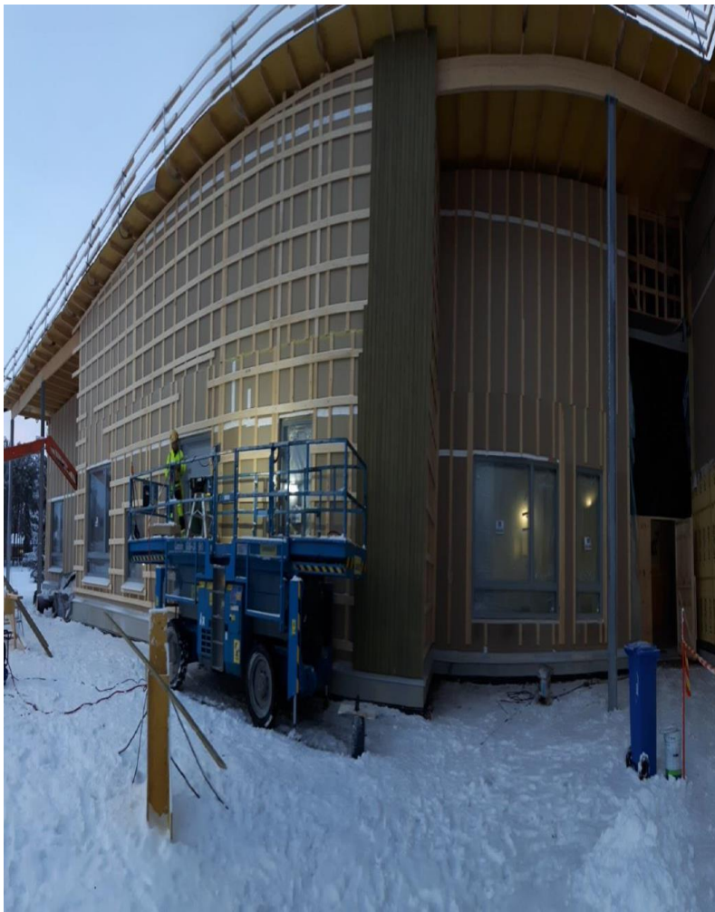
Julkisivun paneelaus 5-6- osalla.
