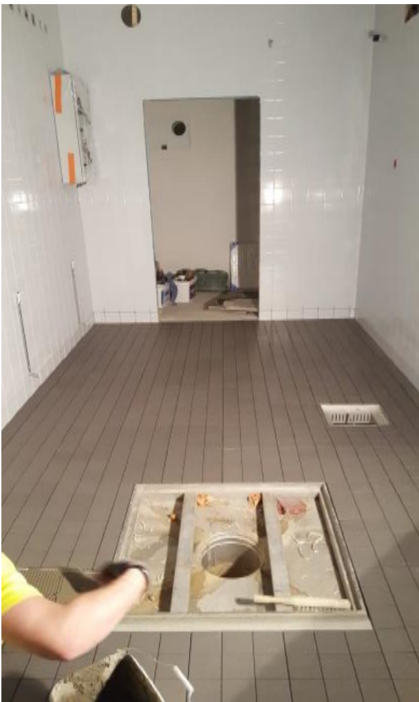
Vss pukuhuoneen laatoitus
